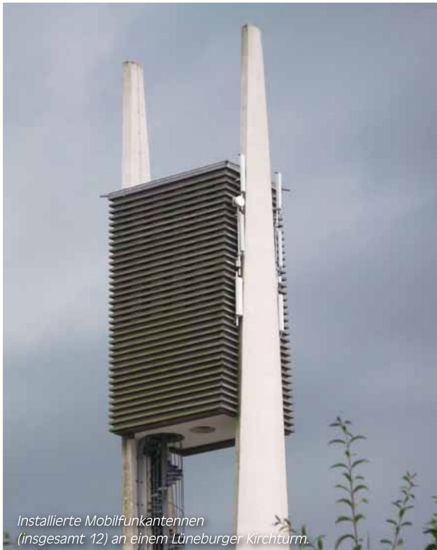
Installierte Mobilfunkantennen (insgesamt 12) an einem Lüneburger Kirchturm.
