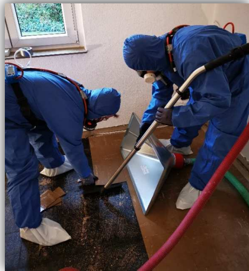
Abbildung: emissionsarmes Sanierungsverfahren BT33
