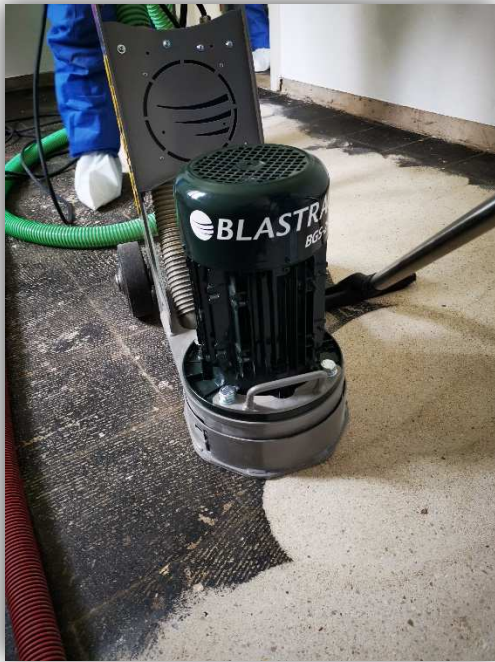
Abbildung: emissionsarmes Schleifverfahren BT33
